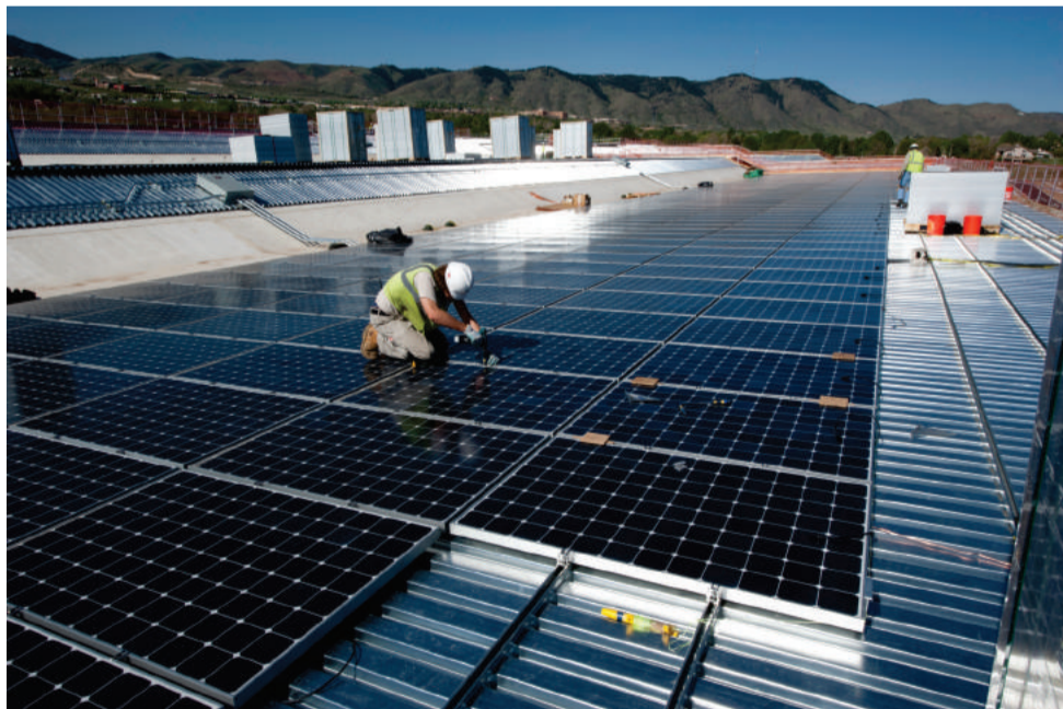
Instalación de placas solares en la cubierta de una empresa | Imagen cedida por Ecovatios
